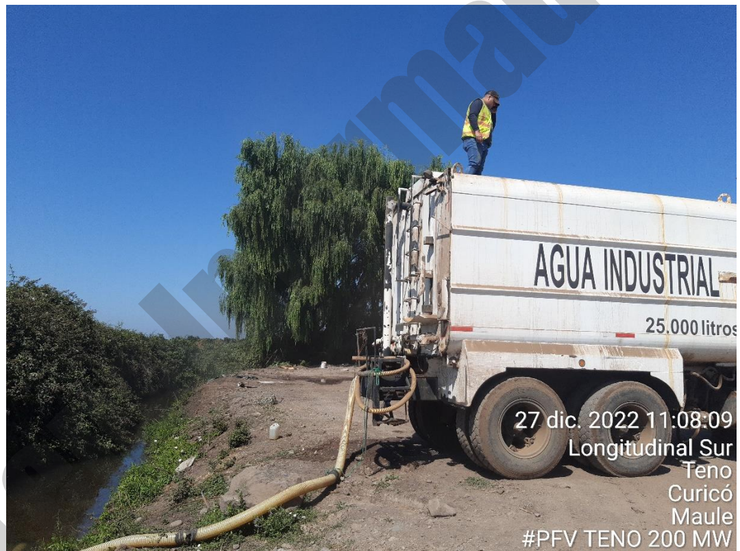
Figura 2. Extracción de agua para humectación en canal interno área proyecto. Fuente: registro fotográfico terreno.
