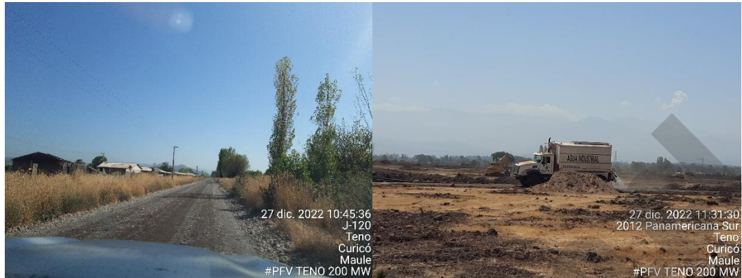
Figura 1. Camino Ruta J-120 humectado y humectación dentro del área del proyecto. Fuente: registro fotográfico terreno.
