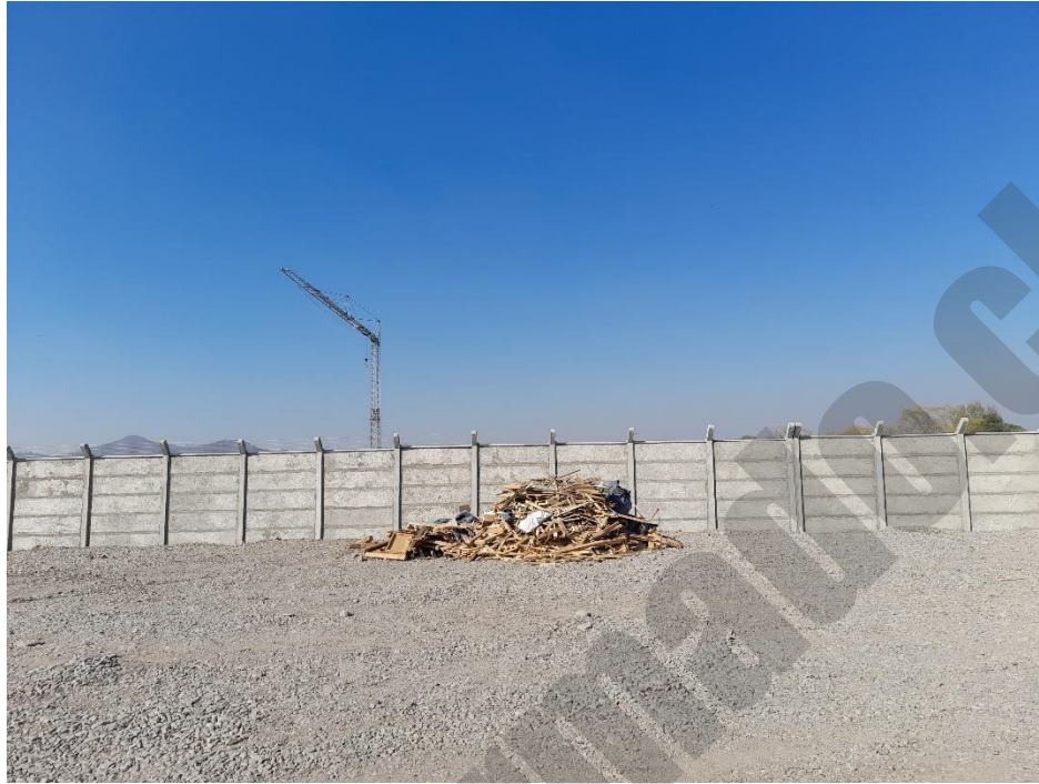
Figura 3. Acumulación de residuos subestación.
