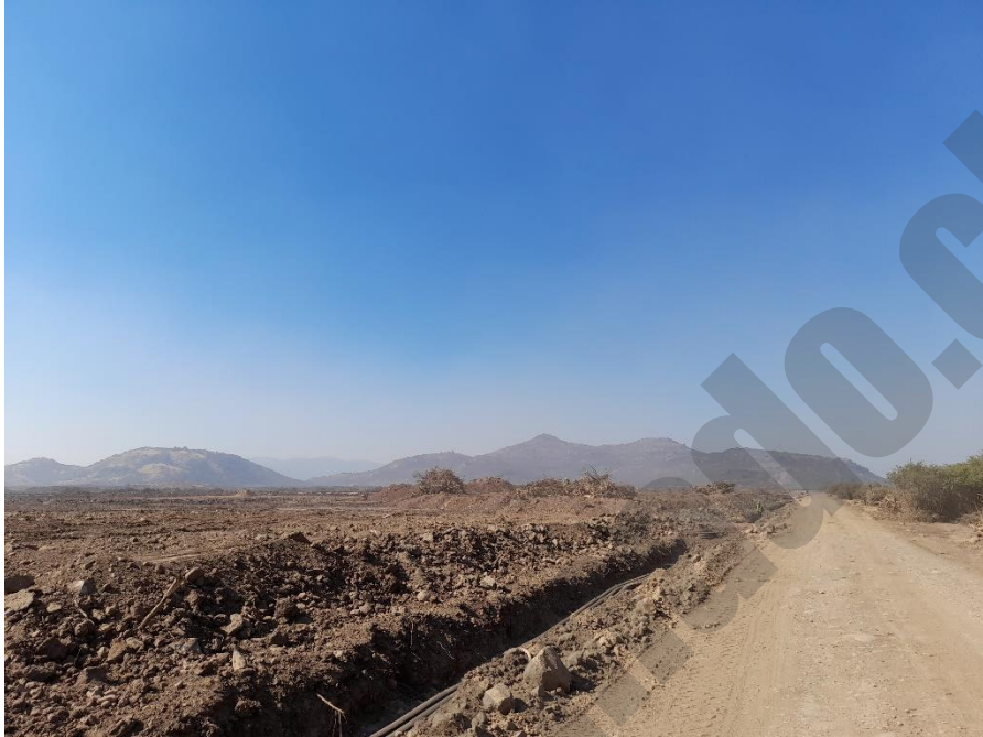
Figura 7. Camino perimetral avanzado y pendiente Fuente: registro fotográfico terreno.
