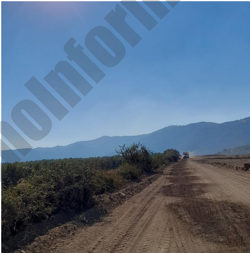
Figura 1. Humectación de caminos. Fuente: registro fotográfico terreno.
