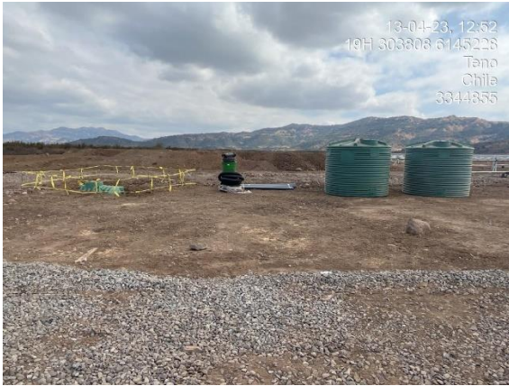
Fosa Séptica en proceso de instalación.
