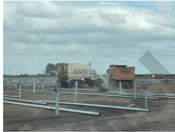
Camión de agua industrial en área de proyecto.
