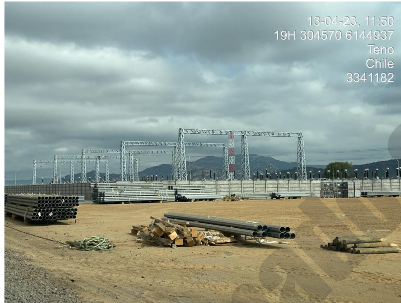
Figura 54. Avance de obras en subestación.
