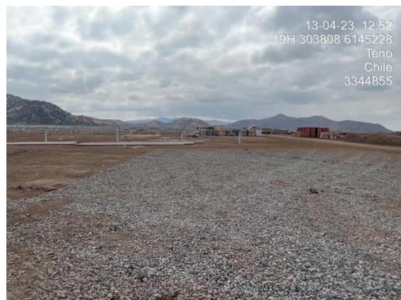
Área instalación de faena 2 (vista nororiente).
