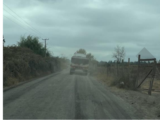
Humectación de camino ruta J-120 y suspensión de polvo frente a viviendas.
