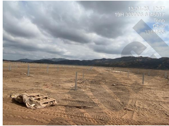
Residuos en sector de trabajos de hincado de paneles cercano al cerro.
