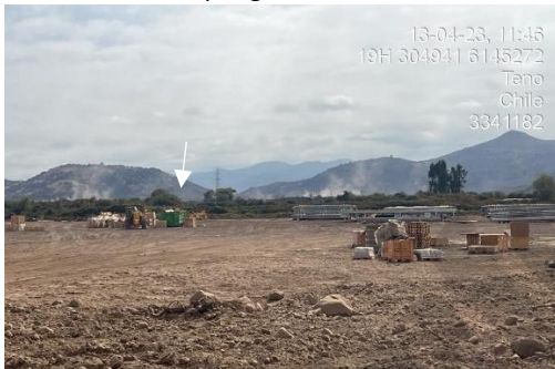
Tolva ubicada en polígono sur
