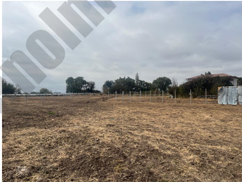
Hincado de estructuras finalizado en el polígono sur, cercano a cierre perimetral acústico de R3.
