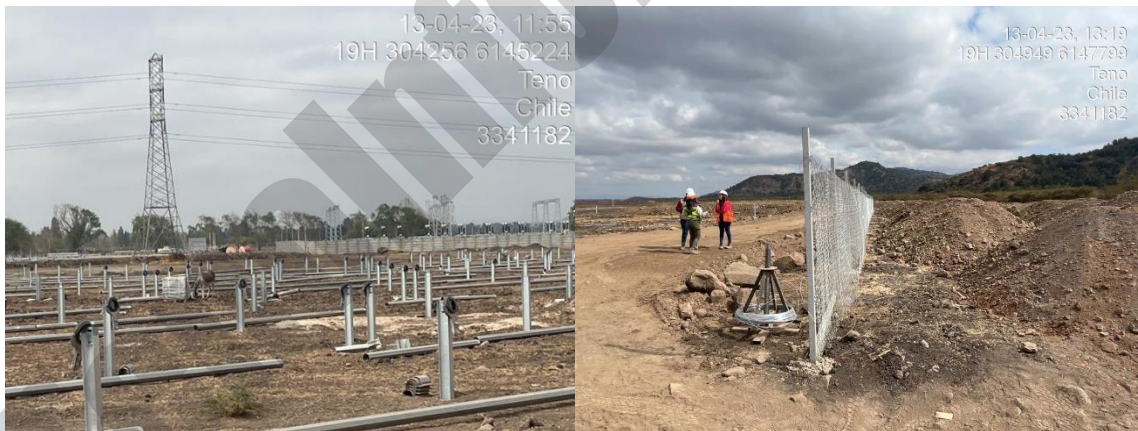
Figura 76. Burro entre hincado de paneles y cerco perimetral malla sector colindante al cerro.
