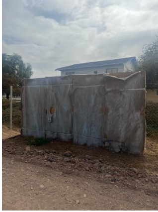
Zona de cierre perimetral temporal de R3.
