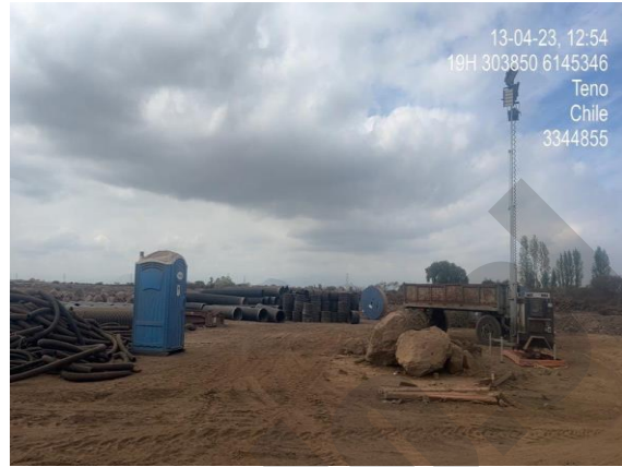
Elementos de la instalación de faena 2.
