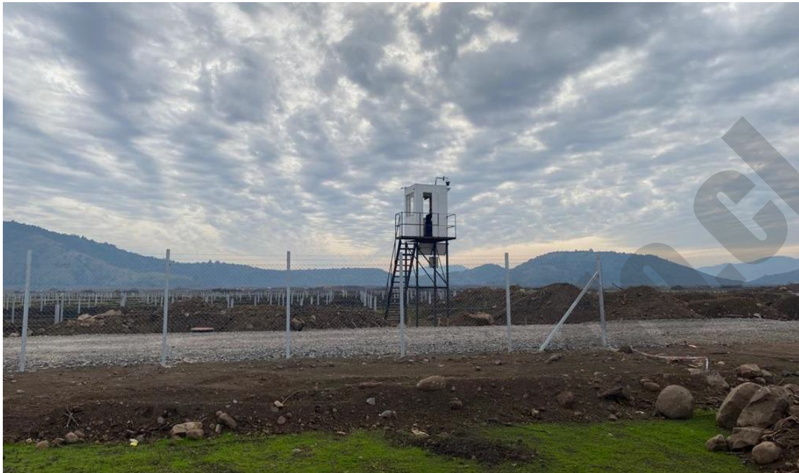
Figura 10. Ubicación de caseta de seguridad, polígono norte.
