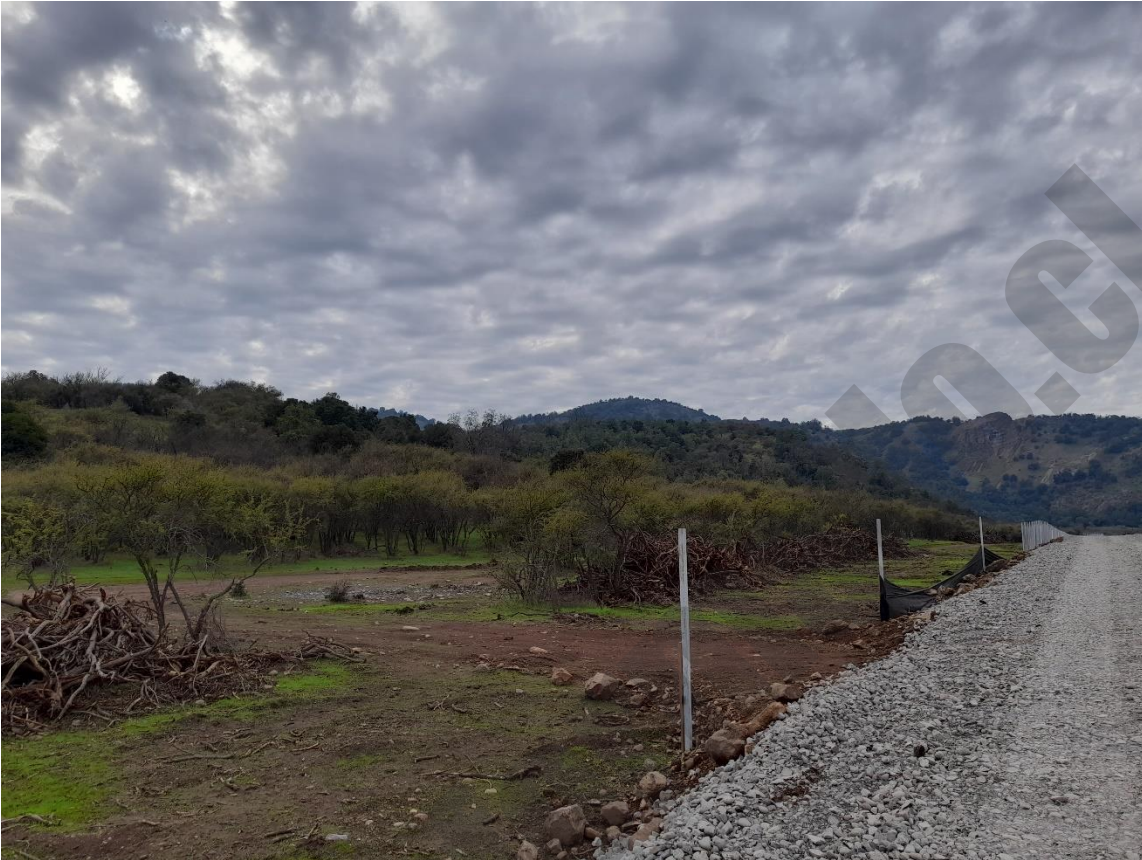
Figura 8. Cerco perimetral y malla raschel sector colindante al cerro.
