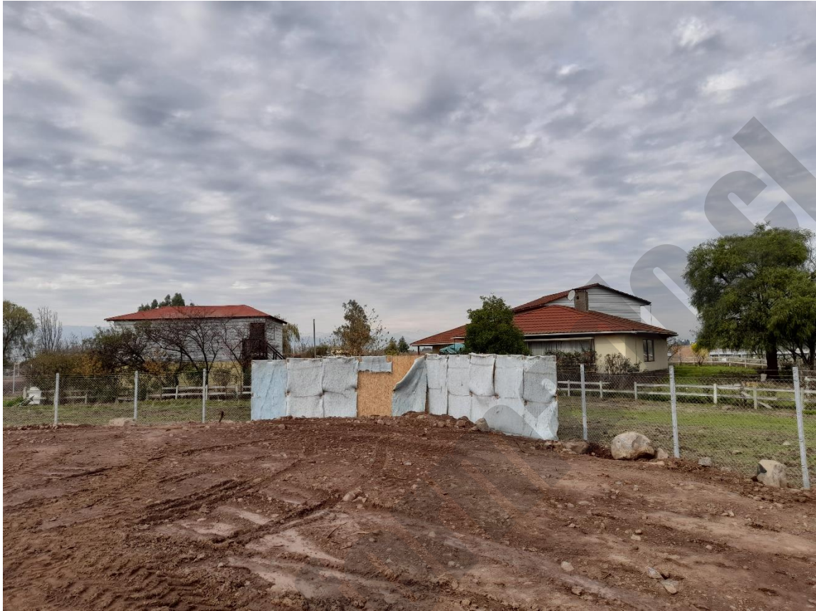
Figura 3b. Barreras acústicas implementadas en R3.
