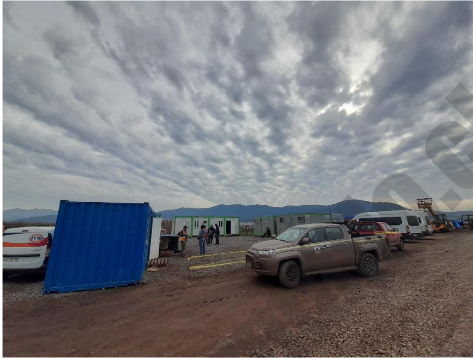
Figura 7. Instalación de faena N°2. Fuente: Registro fotográfico terreno.
