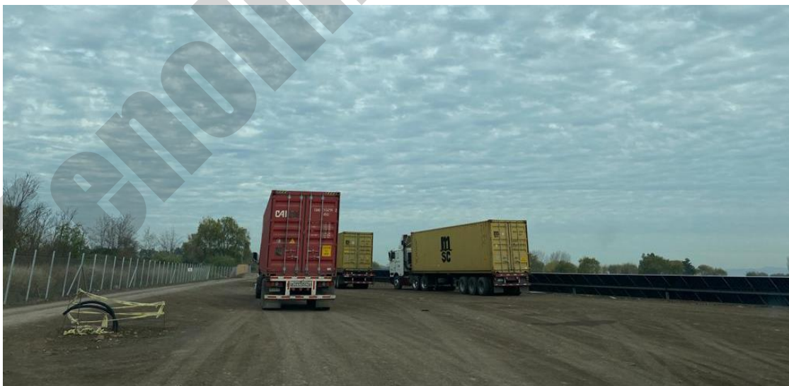
Figura 11. Camiones de transporte de paneles.
