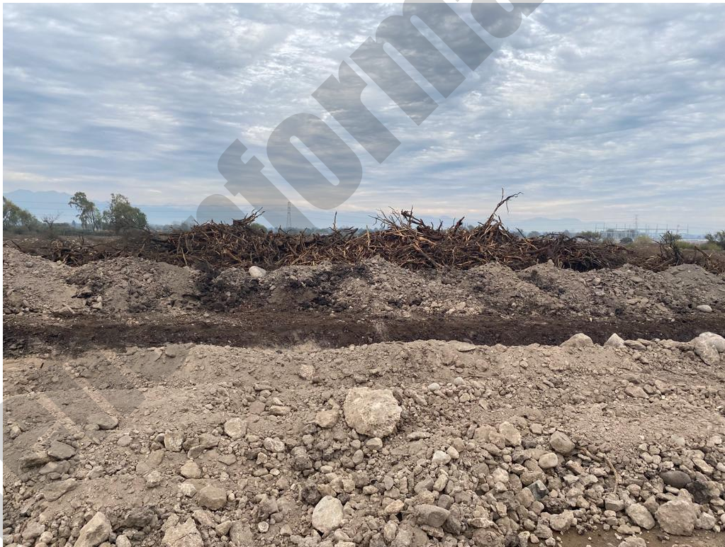
Figura 12. Construcción canal perimetral, obra PAS 156.
