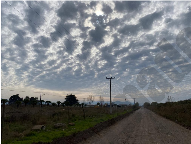
Figura 2. Estado del camino de acceso al proyecto. Fuente: Registro fotográfico terreno.
